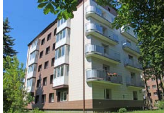
Specialistai svarstantiems, kurį fasadą rinktis renovuojant daugiabutį – tinkuojamąjį ar ventiliuojamąjį, pataria antrąjį variantą, pavyzdžiui, su akmens masės plytelių apdaila.
